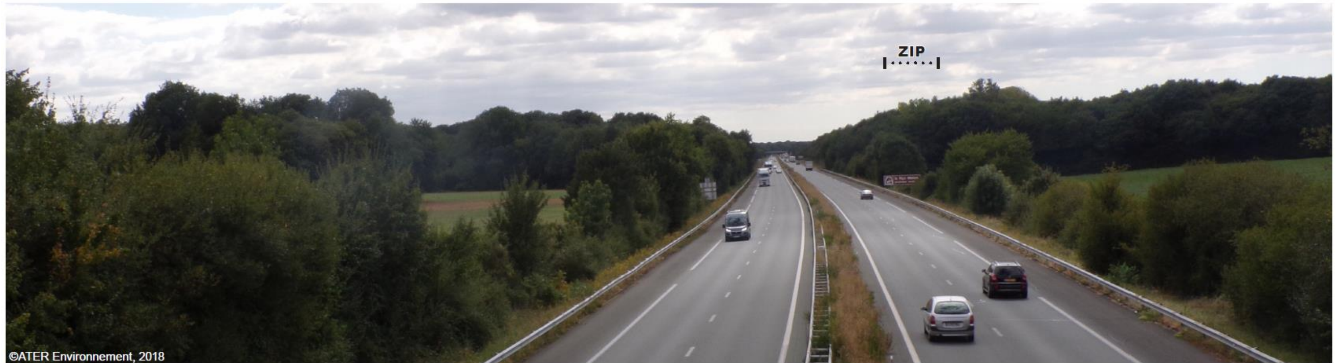
Figure 61 : Vue sur l'A10 au Sud de Saint-Germier
